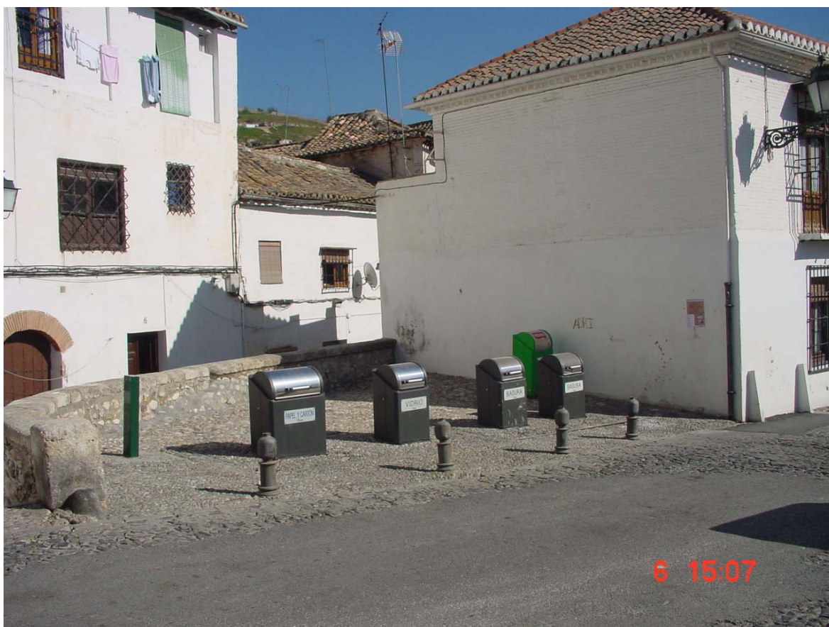
Soterramiento de Contenedores en el Albaicín (5.01.1)
