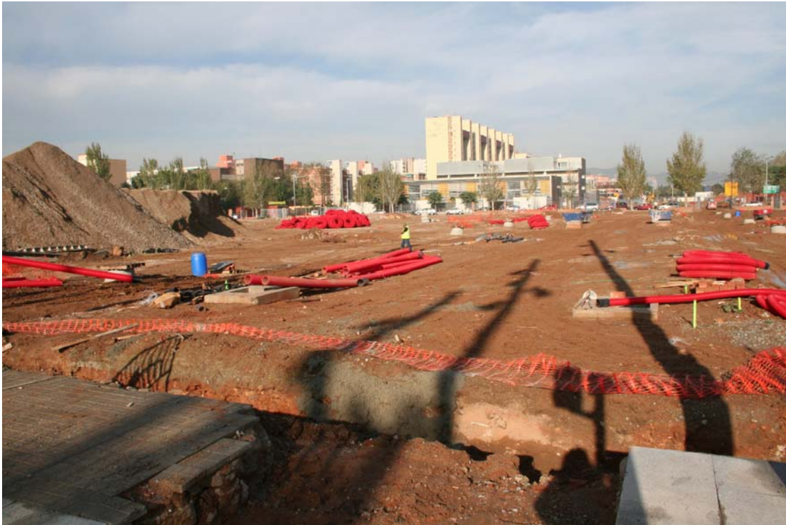
Obras de urbanización de la nueva Rambla de la Mina
