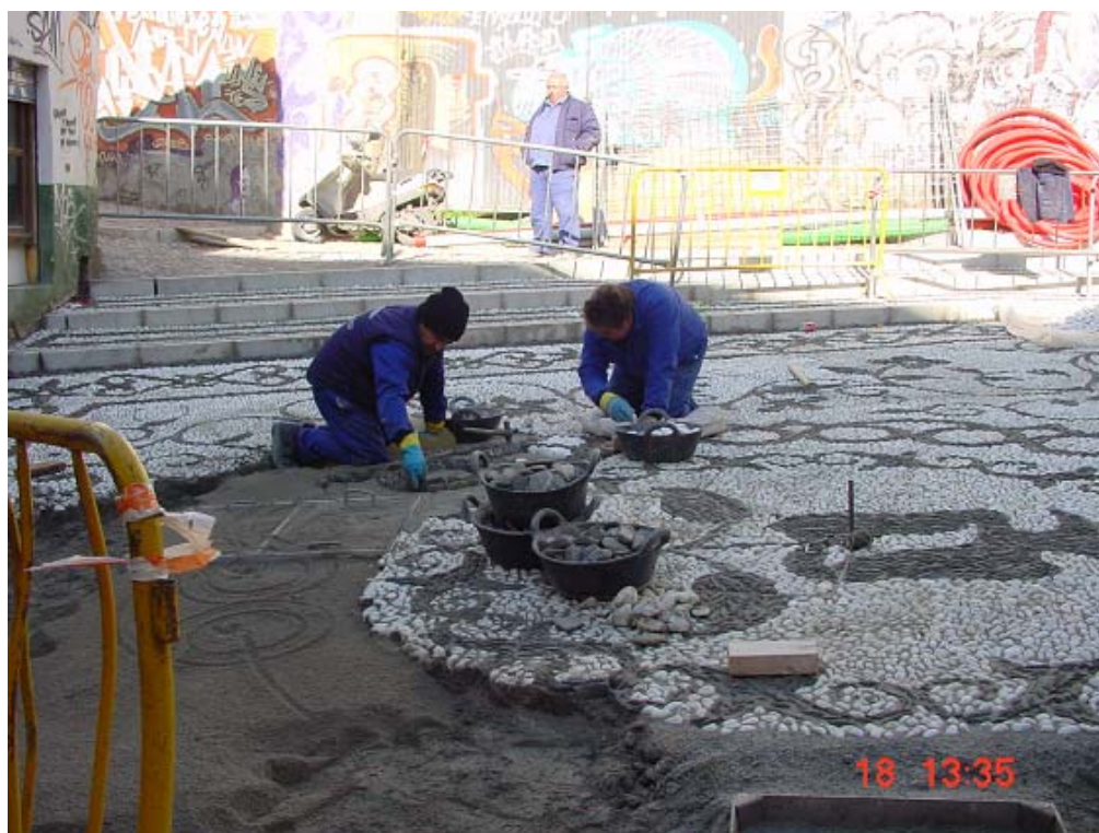
Empedrando las calles del Albaicín. Eje San Jose-Muralla Ziri. 2005
