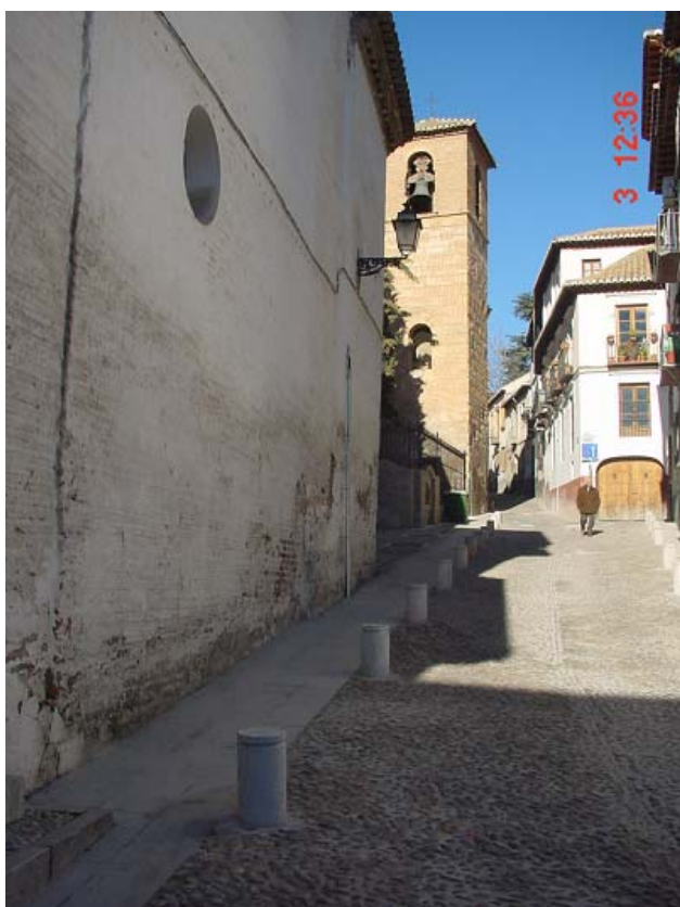
Antes y después de las obras de Reordenación del Eje San José – Muralla Ziri. 2005
