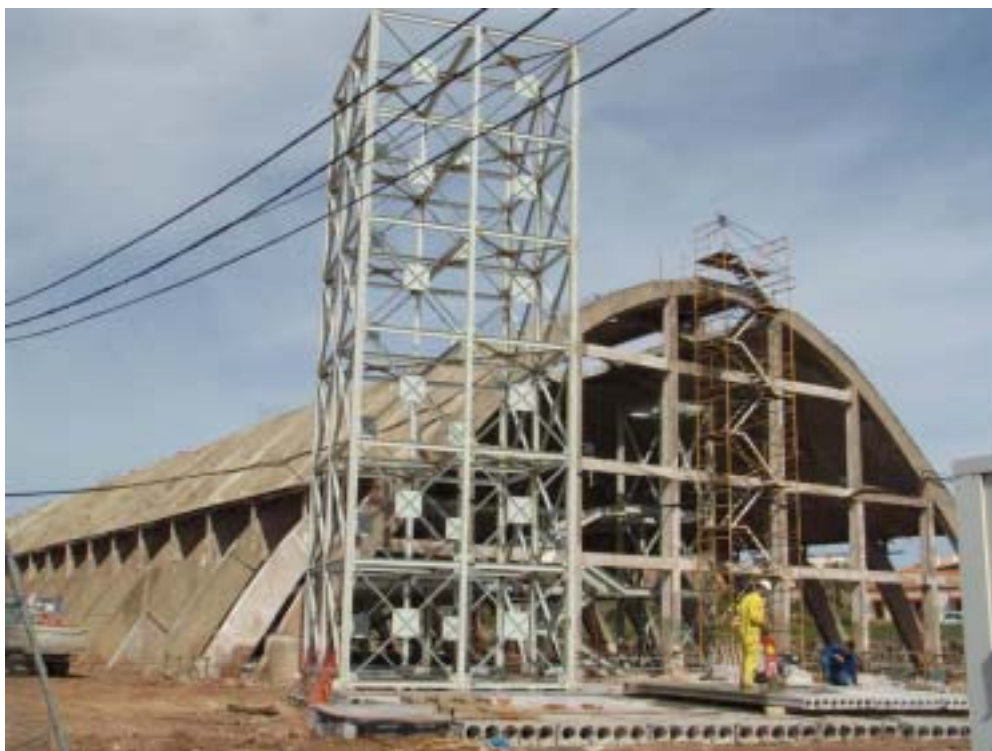
OBRAS DE REHABILITACIÓN DEL EDIFICIO EMBARCADERO (EJE 1)
