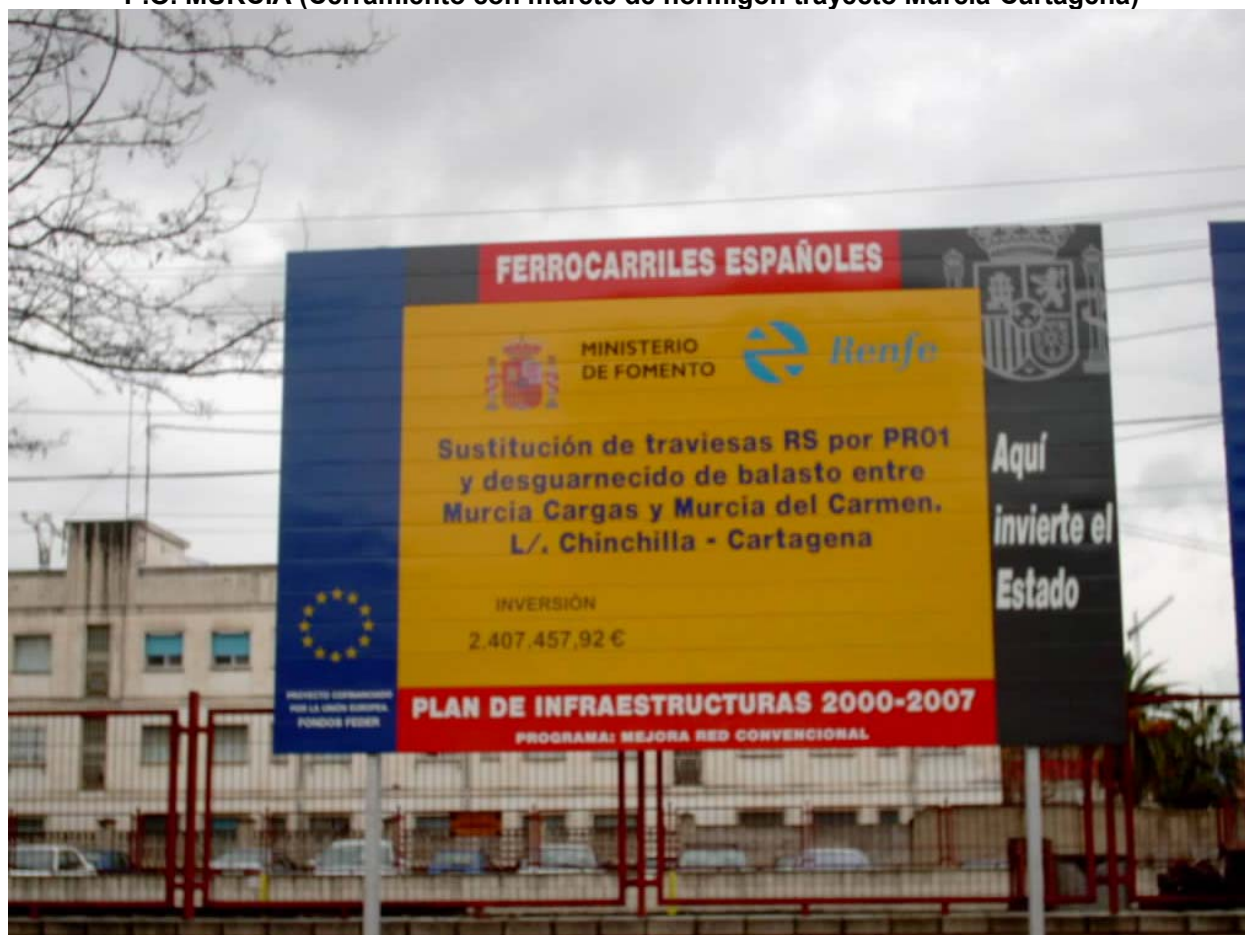
P.O. MURCIA (Sustitución traviesas y balasto t/Murcia Cargas- Murcia del Carmen)
