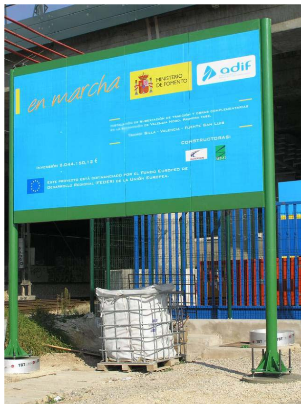
Instalación subestación tracción y obras complementarias estación de Valencia (1ª fase)
