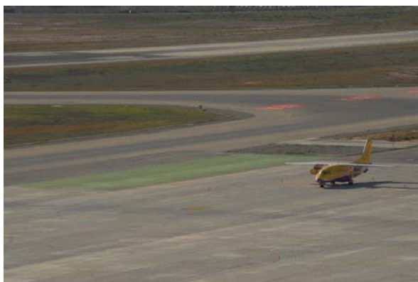
Pavimentación isletas en Plataforma. Alicante
