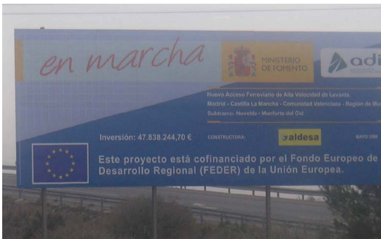
Valla de Obra en las obras de Plataforma del Subtramo Novelda - Monforte del Cid
