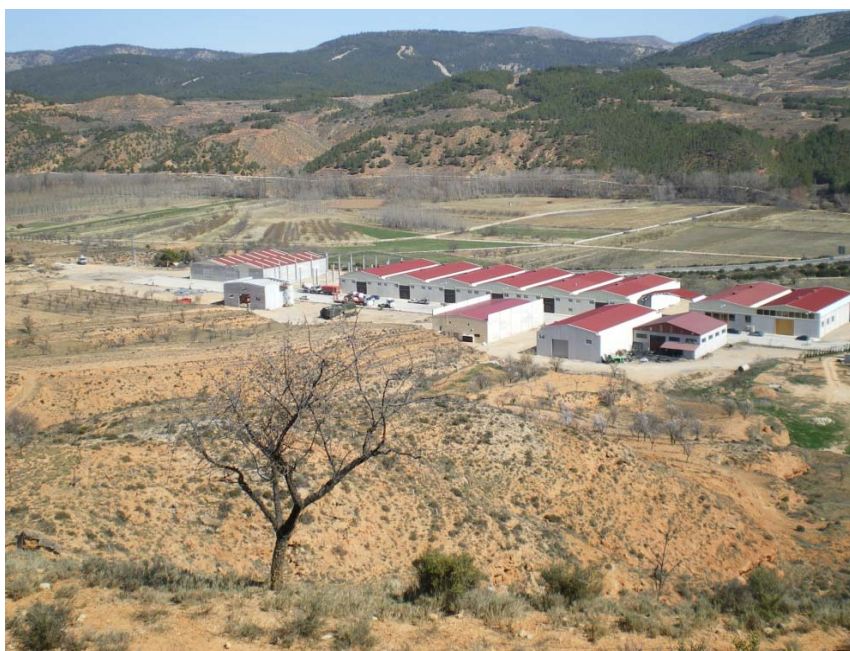
Polígono de Torrebaja
