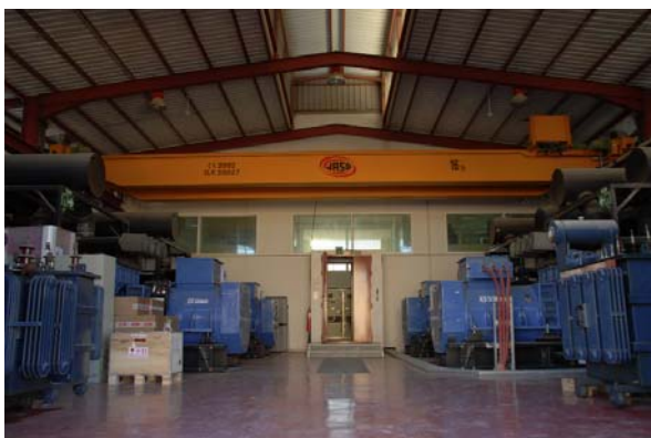
Construcción Subcentral. Alicante
