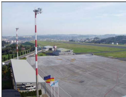
Ampliación Plataforma. Aeropuerto A Coruña
