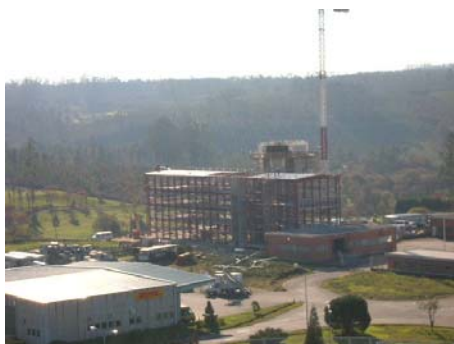
Nueva torre y Centro de Control
