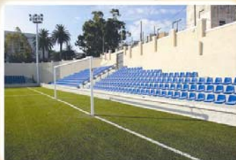
REHABILITACIÓN DEL CAMPO DE FÚTBOL DEL 54 MARTÍNEZ "PIRRI"
