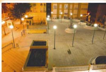
CONSTRUCCIÓN DE LA NUEVA PLAZA DE AZCÁRATE
