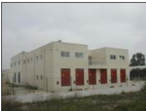
Subcentral Eléctrica. Aeropuerto de Alicante
