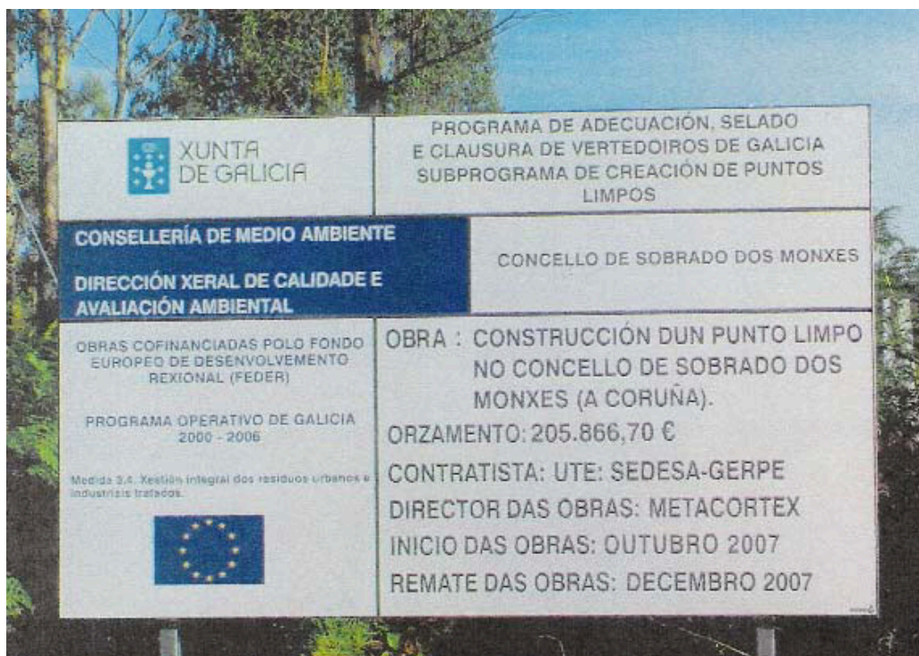
Panel de obra indicativo de la construcción de un punto limpio en el ayuntamiento de Sobrado de los Monjes donde se especifica la financiación con fondos FEDER
