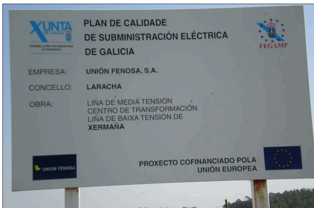
Mejora de la línea eléctrica de media tensión en el ayuntamiento de Laracha.
