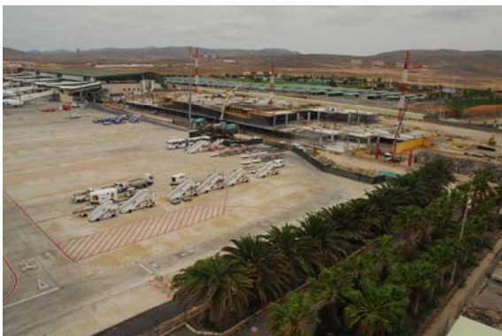
Ampliación Área Terminal. Fuerteventura
