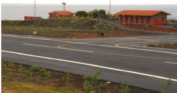
Central Eléctrica. El Hierro
