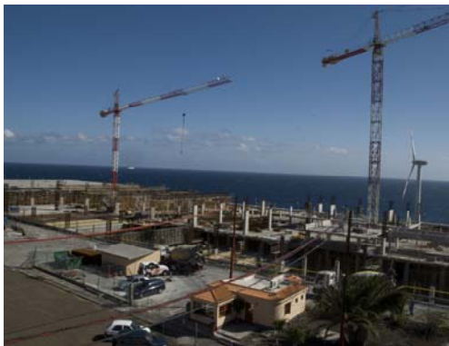
Nueva Área Terminal y Torre de Control
