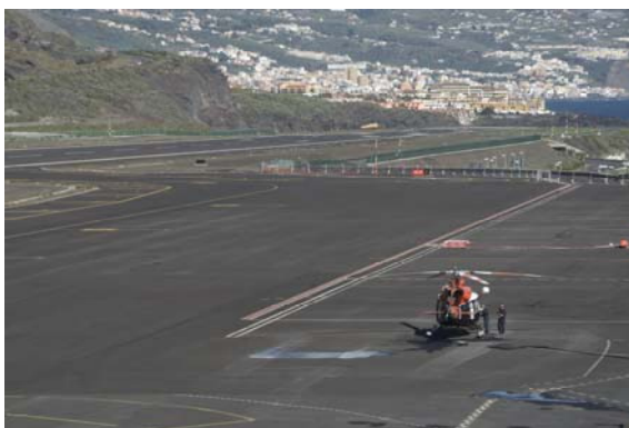
Ampliación de la plataforma. La Palma
