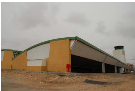
Edificio de tratamiento e inspección de equipajes de salida
