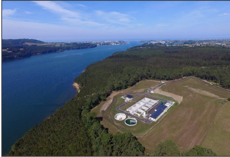
Vista aérea de las instalaciones de depuración
