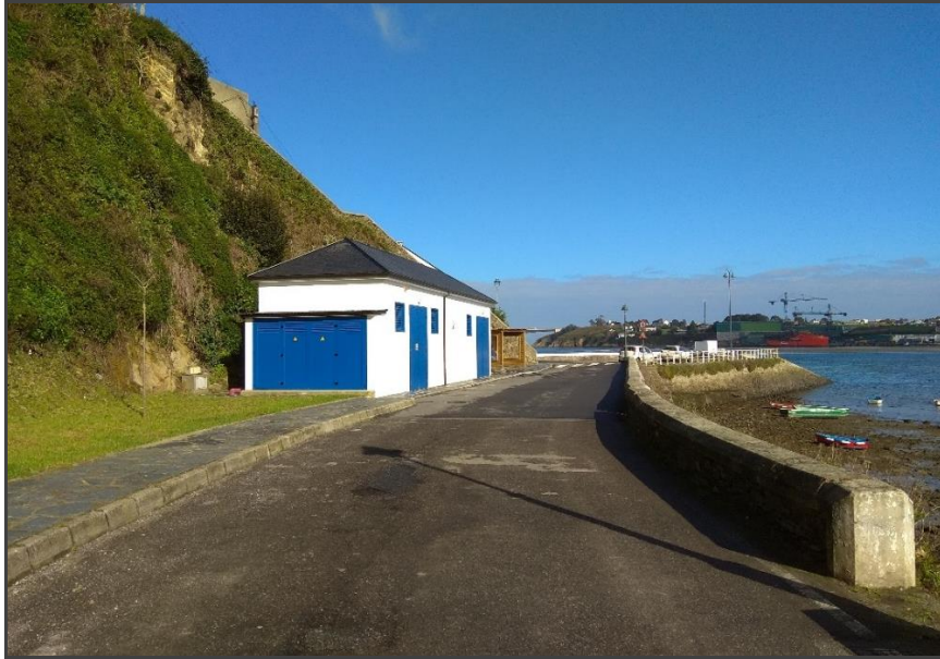
Vista exterior de las instalaciones de bombeo de Castropol
