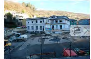
La parcela donde se ubicará el centro de salud, tras los primeros demoliciones. J. R. SILVEIRA
