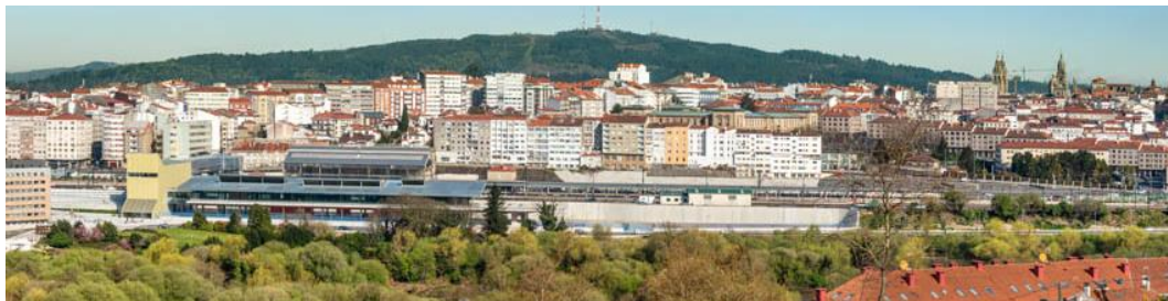
Vista de la Estación Intermodal desde la Ciudad de la Cultura
