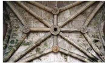
Detalles del techo de la Capilla
