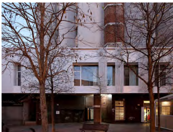
Nueva fachada del Casal rehabilitada
