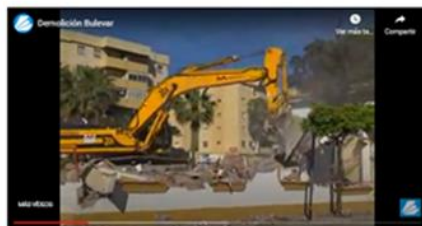
Inicio de las Obras
