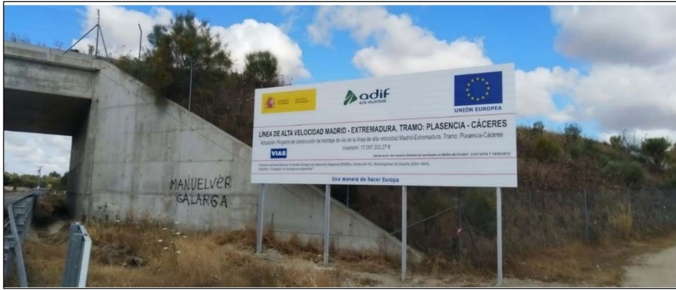
Cartel temporal de obra
