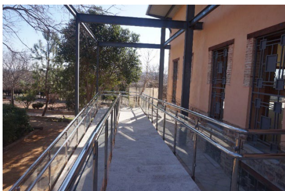
Rampa de acceso a entrada principal.
