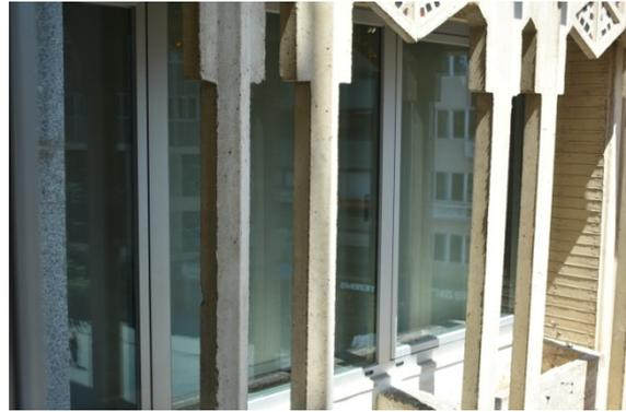
La carpintería actual de la entrada al Ayuntamiento ha sido sustituida por un gran muro de cristal que ocupa toda la superficie de la puerta, compuesto por módulos horizontal realizados con perfiles de aleación de aluminio que permiten amplias zonas de visión tanto desde el interior como desde el exterior. El vidrio es de extrema selectividad y altas prestaciones tanto térmicas, energéticas, acústicas y luminosas.
