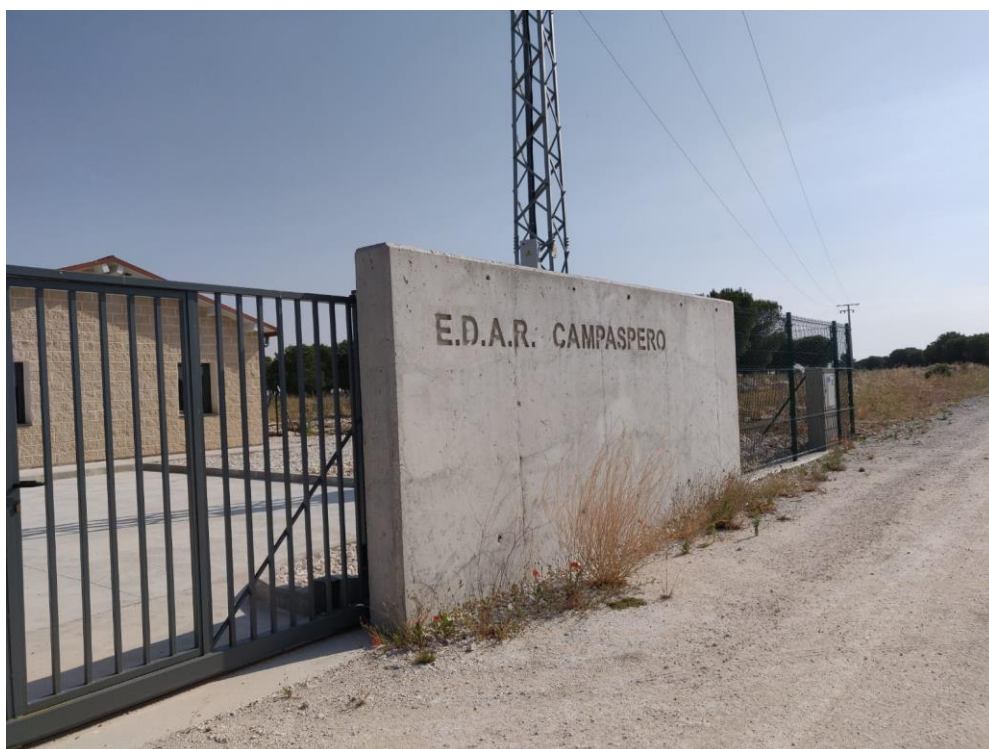
Acceso a la planta depuradora
