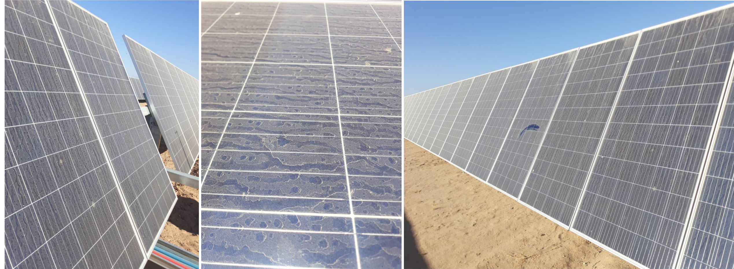
Módulos sucios en parque fotovoltaico
