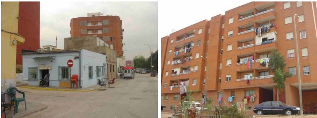
Fotografía 3: Viviendas con alto deterioro social y finca roja al lado del Barranco
