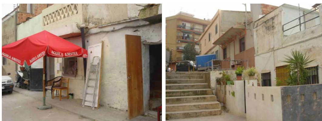
Fotografía 2: Deterioro de vivienda en la C/Lliria
