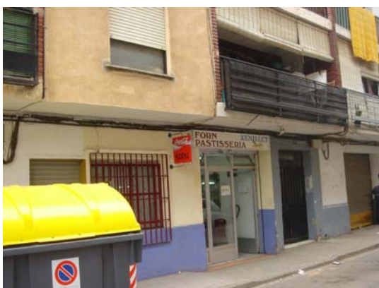
Fotografía 10: Vista del Horno Pastelería del barrio del Xenillet
