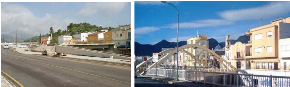
Fotografía 2: Puentes de acceso al barrio de Beniopa
