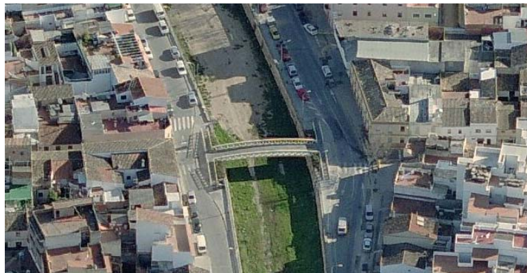
Fotografía 8: Vista de la Pasarela peatonal de Beniopa construida y C/Barranc acondicionada
