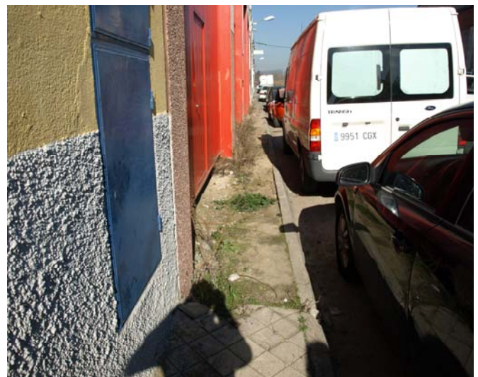
IMAGEN 8. Mal estado de la pavimentación.
