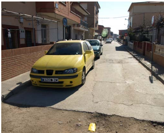
IMAGEN 12. Vialio sin asfaltar.
