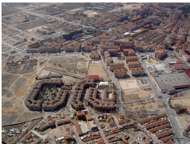
Vista aérea desde el Este de la zona de actuación: en la parte inferior, “La Estrella” y en la superior, “La Milagrosa”.
