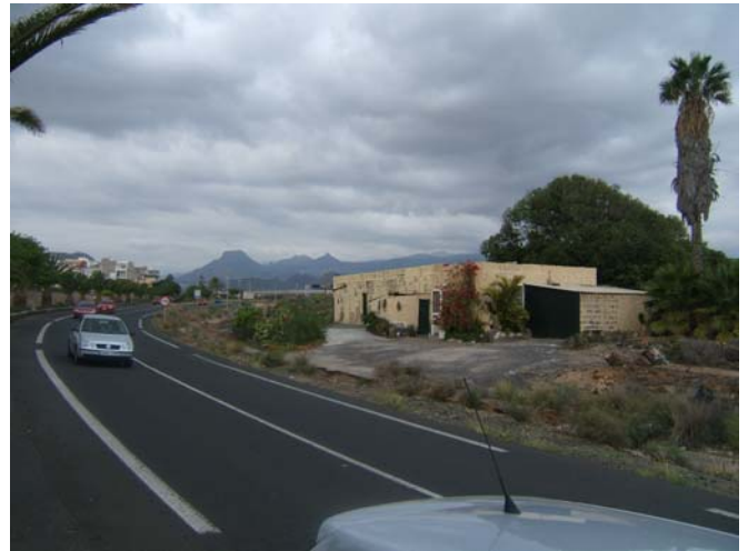
IMAGEN 19. La TF-66 une El Fraile con Las Galletas. Sobre este eje se prevé la actuación del Corredor Verde El Fraile – Las Galletas
