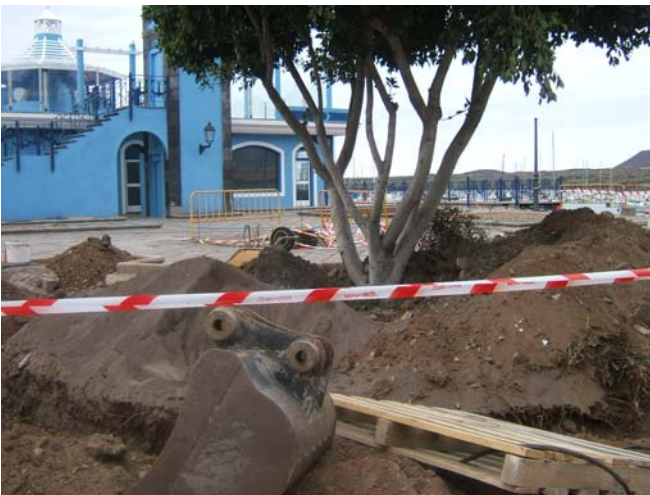
IMAGEN 11. Obras de mejora y adecuación del Puerto Deportivo de Las Galletas y el paseo marítimo
