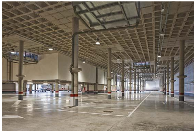
Intercambiador de Padre Anchieta.
