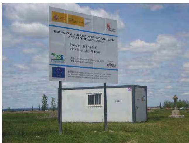
Cartel de obra del proyecto con la referencia a la cofinanciación europea.
