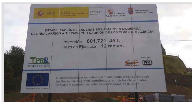
Cartel de obra del proyecto colocado en la obra.
