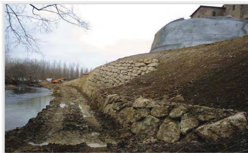
Estabilización de la ladera de la margen izquierda del río Carrion a su paso por Carrion de los Condes.
