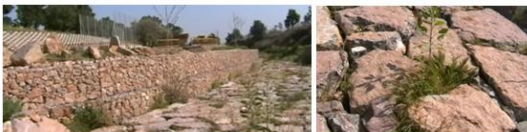
Detalle del encachado de piedra que armoniza con los gaviones en los taludes y enriquece paisajísticamente el entorno.
