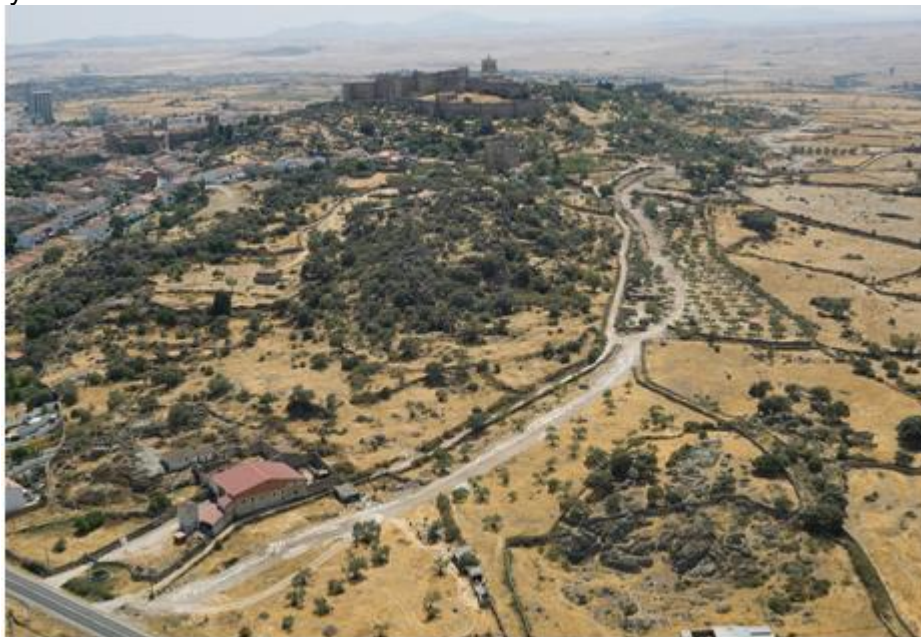
Tubería a su paso por Trujillo
