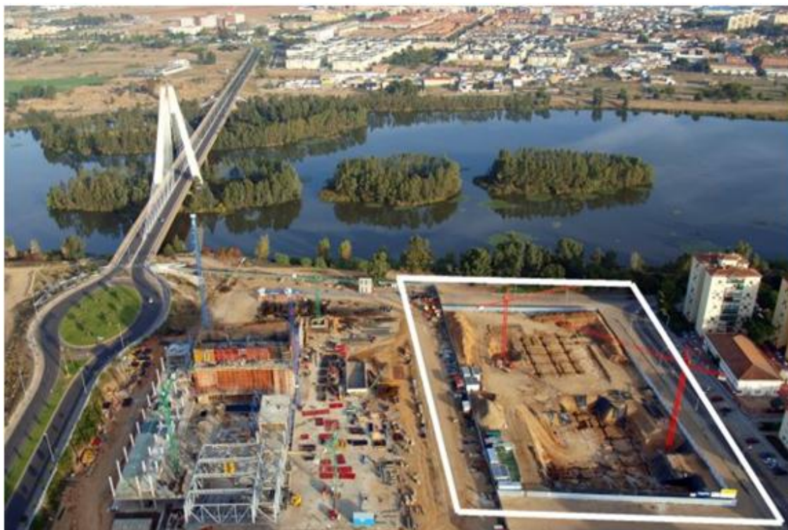
VISTA AÉREA DURANTE LA FASE DE CONSTRUCCIÓN.
