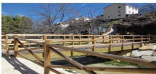
Vistas de la talanquera colocada en la zona de El Plantón del Covacho (foto superior) y la que protege la nueva pasarela que conecta el casco urbano con la ruta ecoturística.
