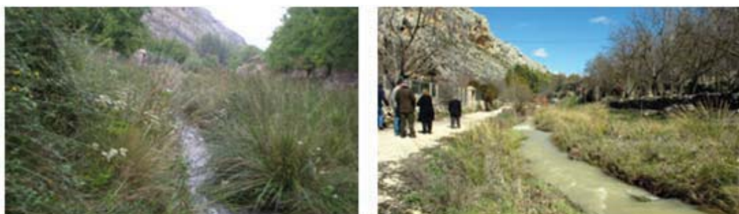
Fotografías del antes y el después, donde se observa la mejora de la capacidad hidráulica del río Taibilla, la eliminación de vegetación intrusiva del cauce y el acondicionamiento de senda peatonal para disfrute de los ciudadanos.
