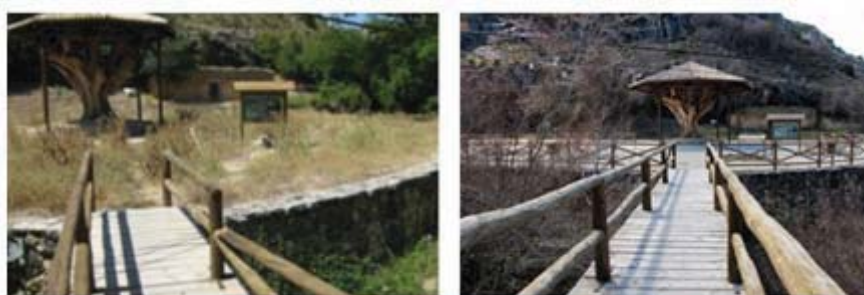
Fotografías del antes y el después: Mejora del acceso al Plantón del Covacho
