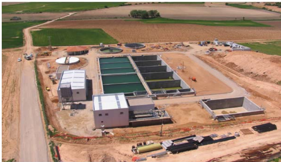
Fotografía aérea de la infraestructura en obras
