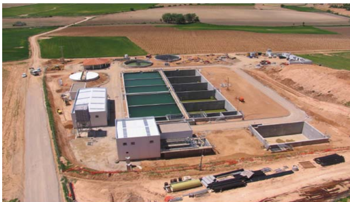
Fotografía aérea de la infraestructura en obras
