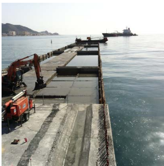
Vista de la prolongación del dique
