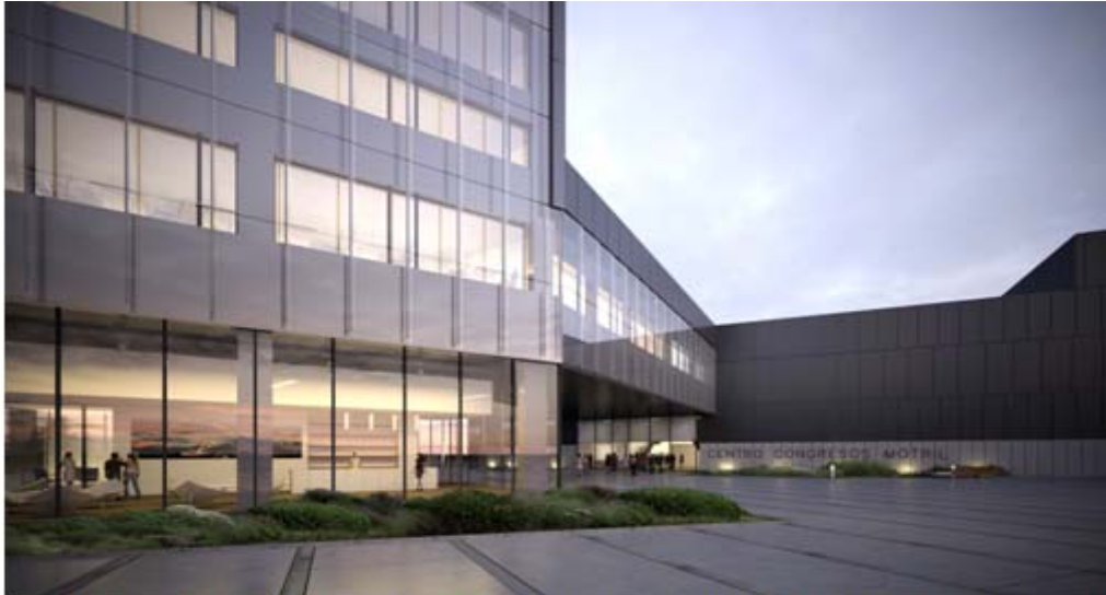
Vista exterior nocturna de la plaza de acceso (izquierda, Oficina Recepción Visitantes (Oficina de Turismo). Frente, Centro de Congresos
