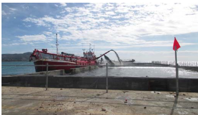
Draga rellenando cajones
