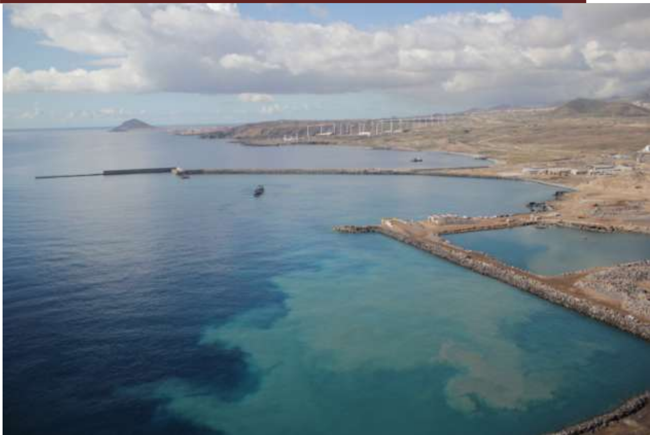
Ilustración3. Vista aérea de las obras.
