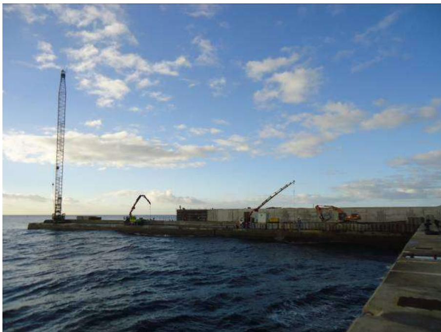
Ilustración 5. Vista de las obras del contradique incluidas en el proyecto de obras de abrigo.
