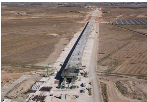
Ejecución de tablero mediante cimbra autolanzable, la cimbra se apoya en las propias pilas del viaducto, no necesitando apoyos en el propio terreno.
