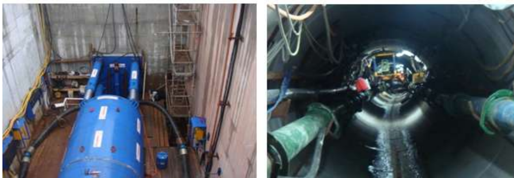
Sistema de guiado LASER Láser teodolito instalado en hinca en curva
