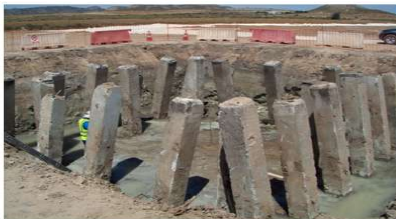
Conjunto de pilotes tras la hinca
