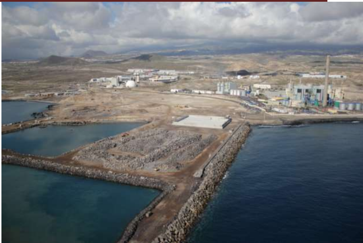
Ilustración 4. Vista del dique talud Norte del puerto de Granadilla
