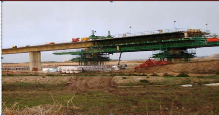
Ejecución de tablero mediante cimbra autolanzable, la cimbra se apoya en las propias pilas del viaducto, no necesitando apoyos en el propio terreno.
