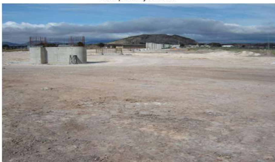
Pilas en ejecución en diferente fase de alzado.
