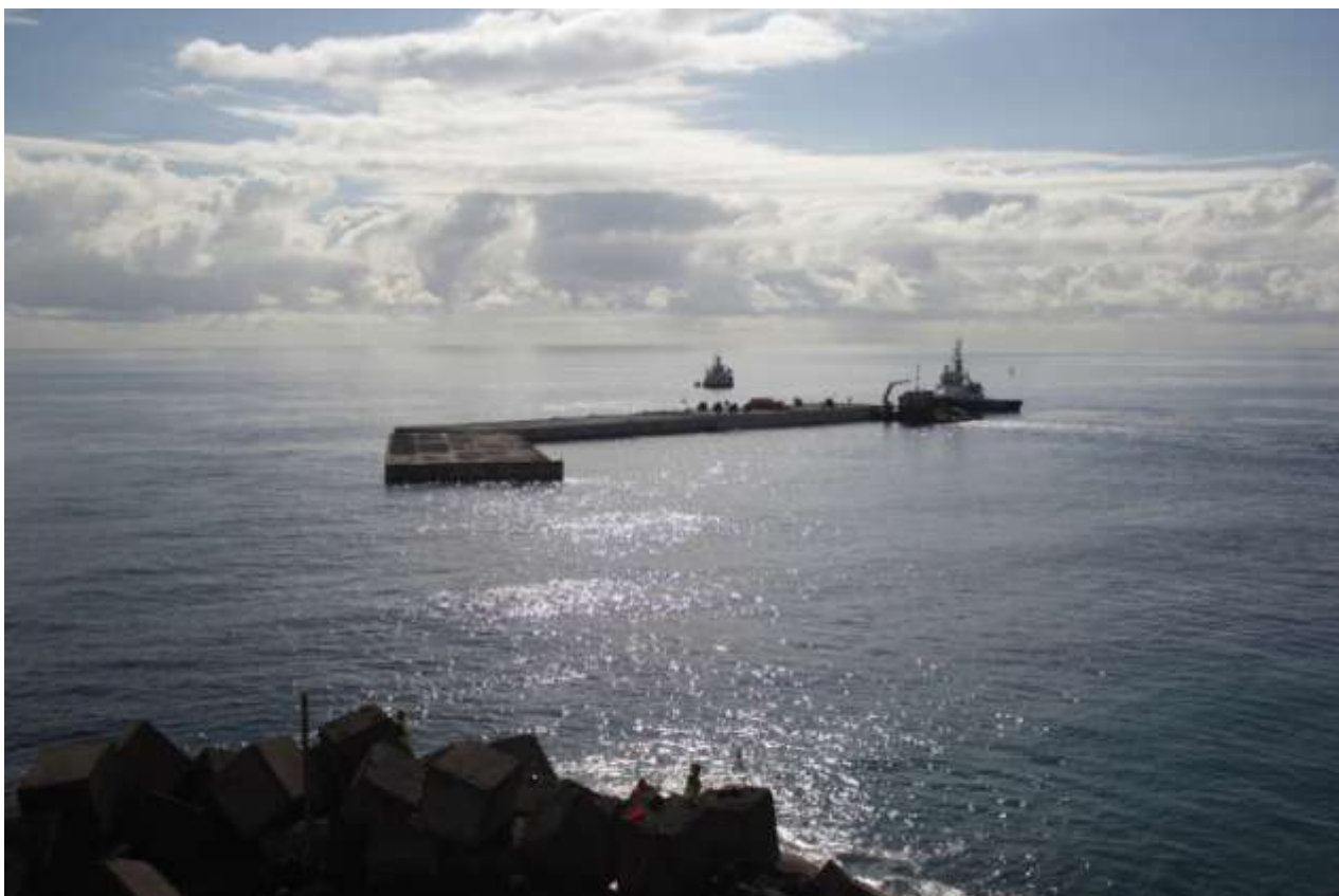
Imagen 1. Vista de los cajones del quiebro de la primera y segunda alineación del dique exterior.
