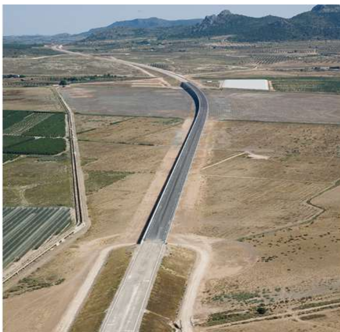
Vista panorámica Viaducto sobre el camino del Cordel del Sax
