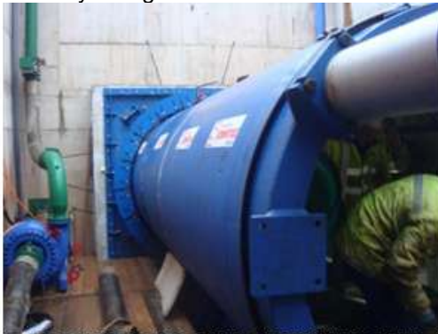
Emboquille 1er modulo microtuneladora AVN2000D Bomba de extraccion
