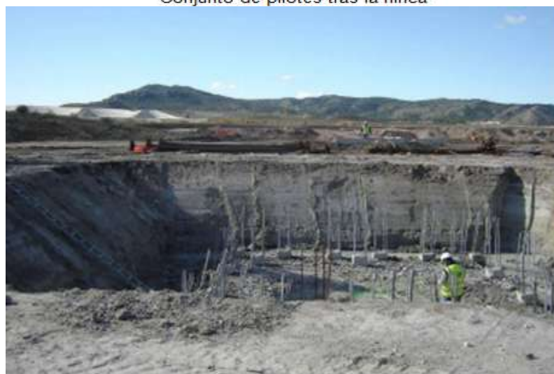
Pilotes descabezados, preparados para la ejecución del encepado
