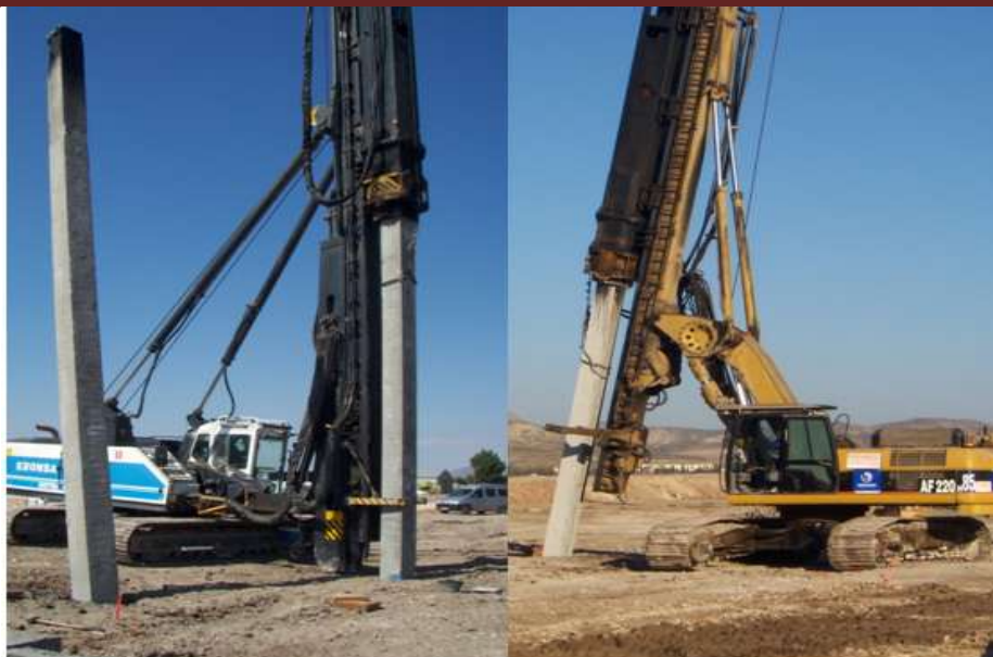
Hinca de Pilotes
