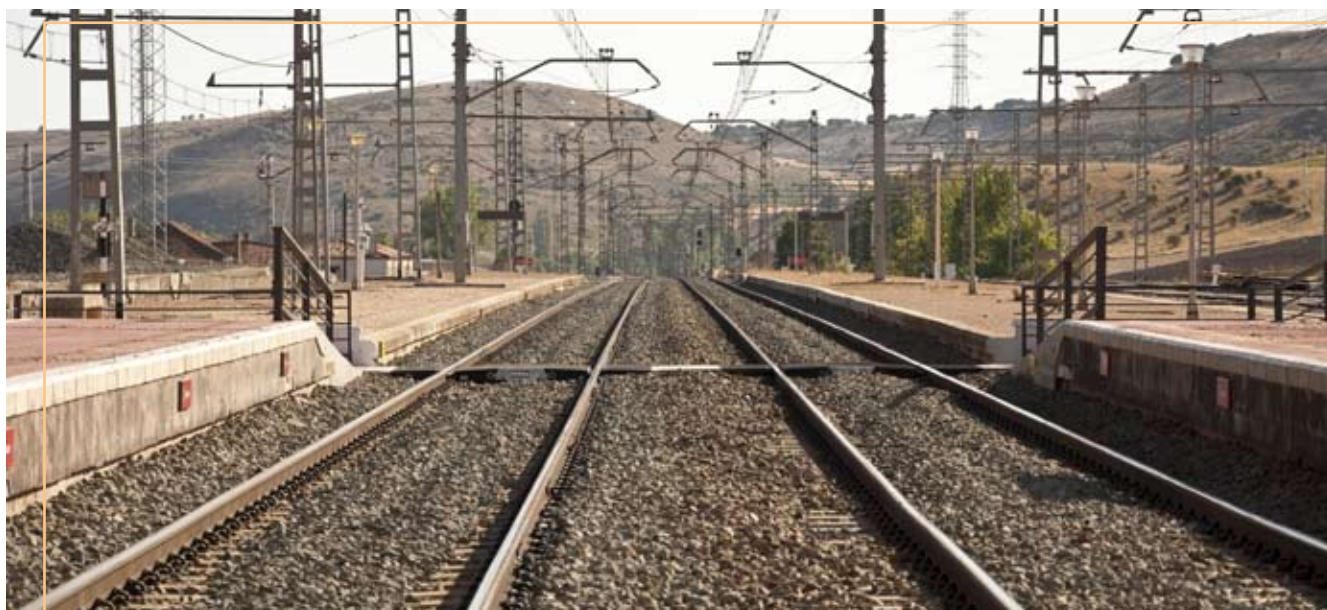
Se han reconstruido estaciones y equipado con modernos sistemas de información.
