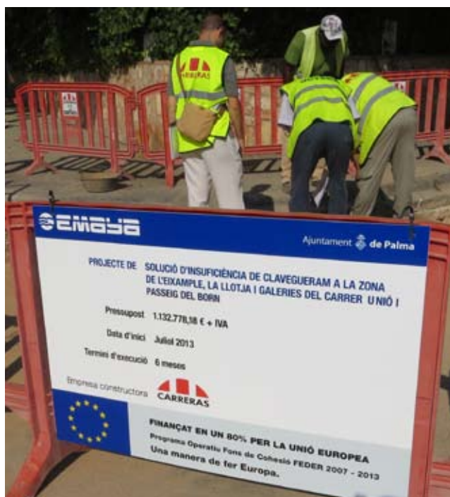
Obras en la zona de la Lonja
