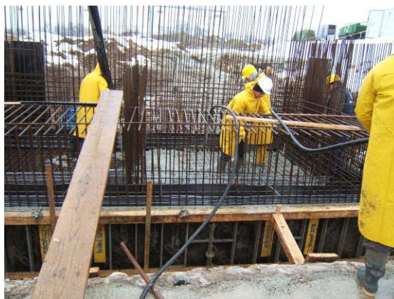
Cimientos de hormigón vertido
