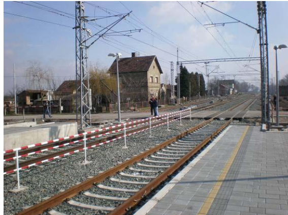
Estación de Deletovci. Vista este
