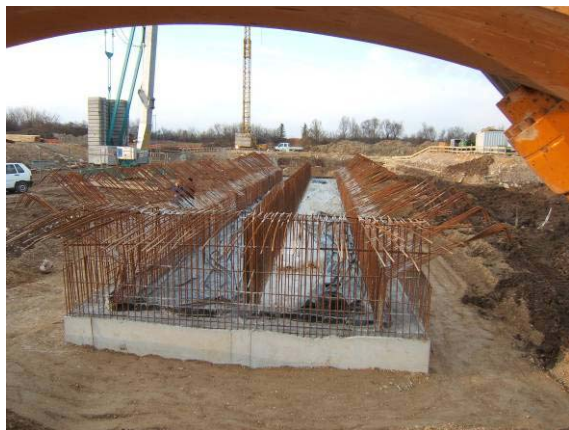
Construcción de los cimientos
