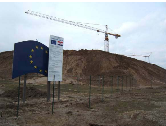
Entrada a la obras de construcción
