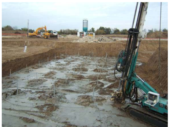
Excavación y levantamiento de pilares
