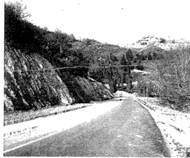
Imagen de las obras realizadas en la carretera de La Coboerola.
