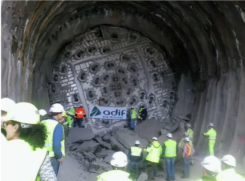
Foto: Cale de la tuneladora por lado Este.
