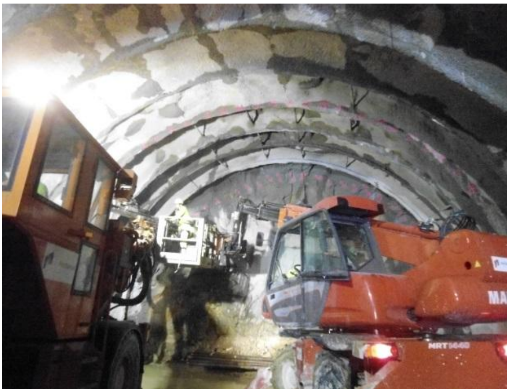
Foto: Sostenimiento de la excavación: Colocación de cerchas Túnel de Vilavella
