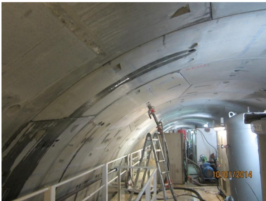
Foto: Reinyección de mortero bicomponente para aseguramiento de completo llenado de Gap.
