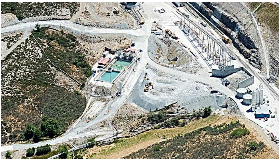
Foto: Ejecución de planta de depuración de aguas del túnel
