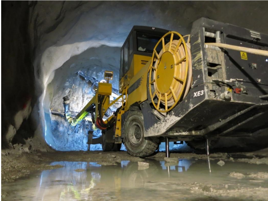
Foto: Perforación con jumbo para bulones Túnel de Prado Vía derecha
