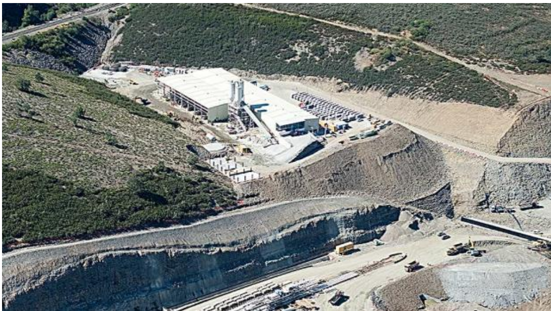
Foto: Planta de fabricación de dovelas
