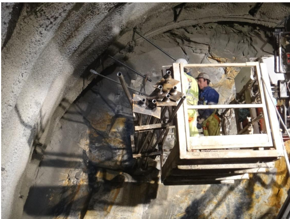
Foto: Colocación de bulones Túnel de Prado Vía derecha
