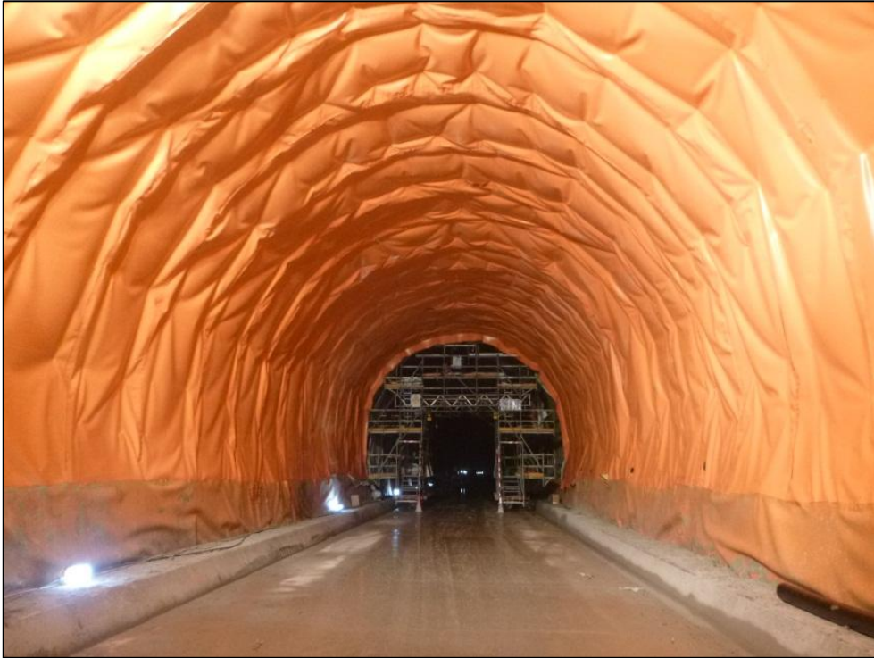
Foto: Colocación de la impermeabilización de la bóveda del Túnel De O Cañizo Vía Derecha
