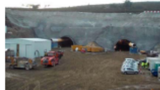
Zona de emboquille de entrada del túnel
