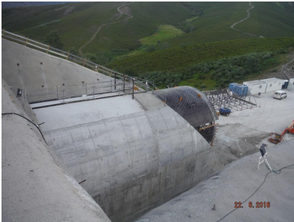
Foto: Falso túnel del lado Este
