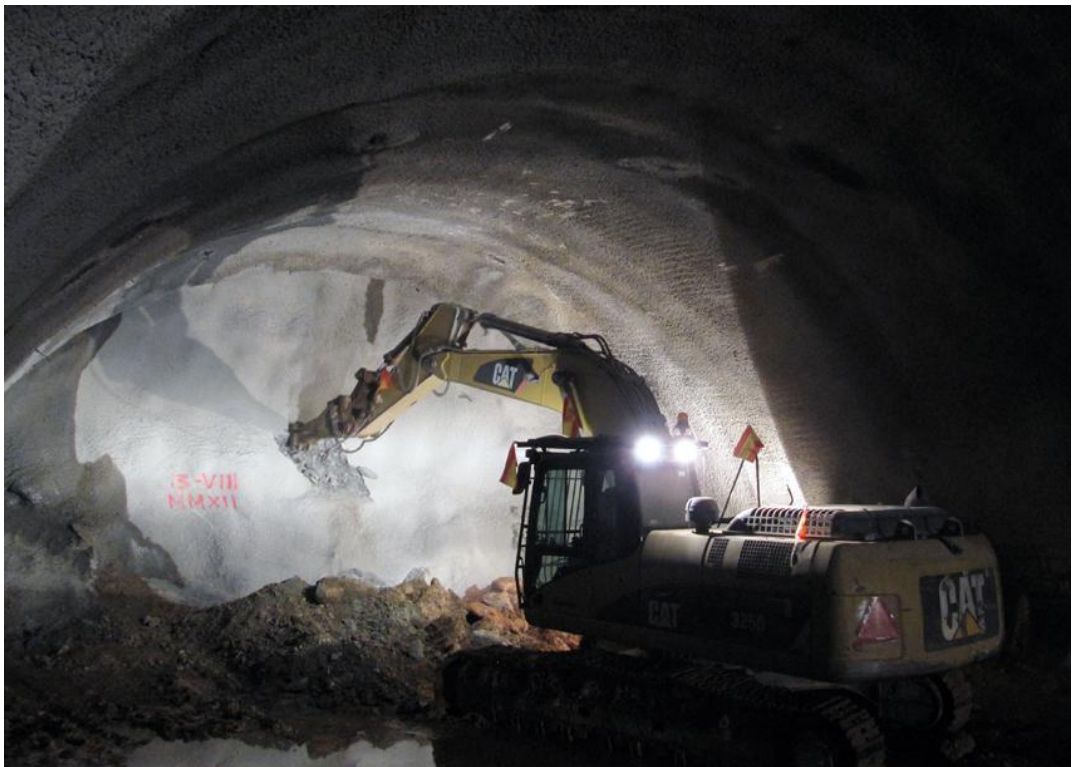
Foto : Fase final de la perforación del túnel de Santa Marina
