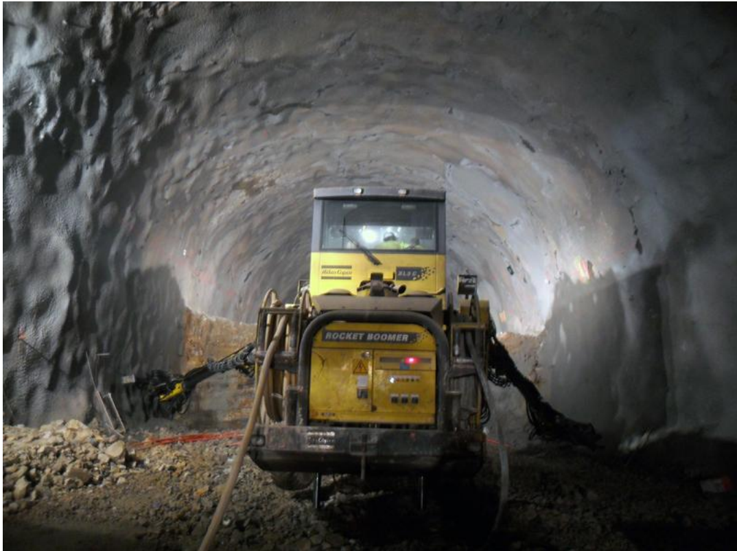
Foto : Perforación (fase destroza) en la boca sur del túnel
