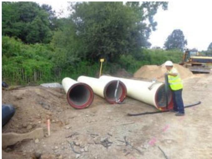
Tubería de fundición con revestimiento exterior PUX y junta acerojada
