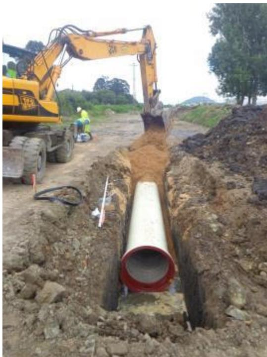
Colocación de tubería PUX acerrojada en zanja
