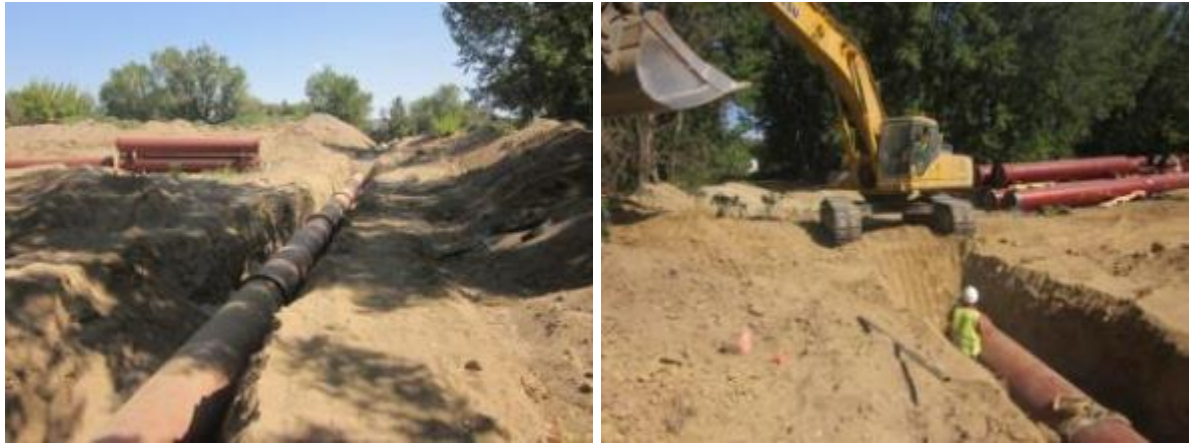
Nuevo emisario de salida. (Agosto 2015)
