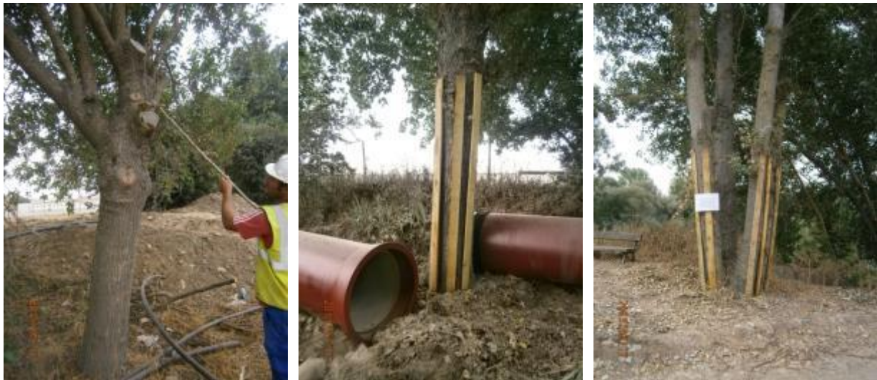
Protección de vegetación existente y aplicación de cicatrizantes en ramas podadas
