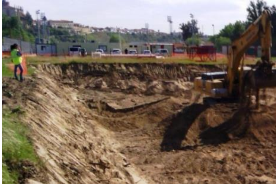
Supervisión arqueológica a pie de obra
