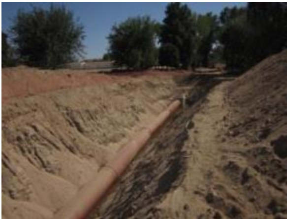
Nuevo colector de llegada de agua bruta
