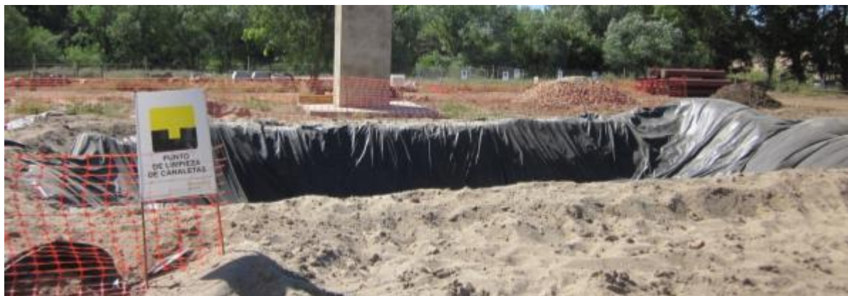
Implantación de un punto de limpieza de cubas de hormigón
