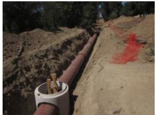
Nuevo colector de llegada de agua bruta
