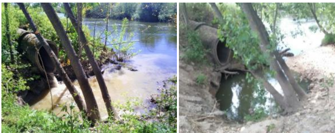
Aliviadero de cabecera antes y después de las obras
