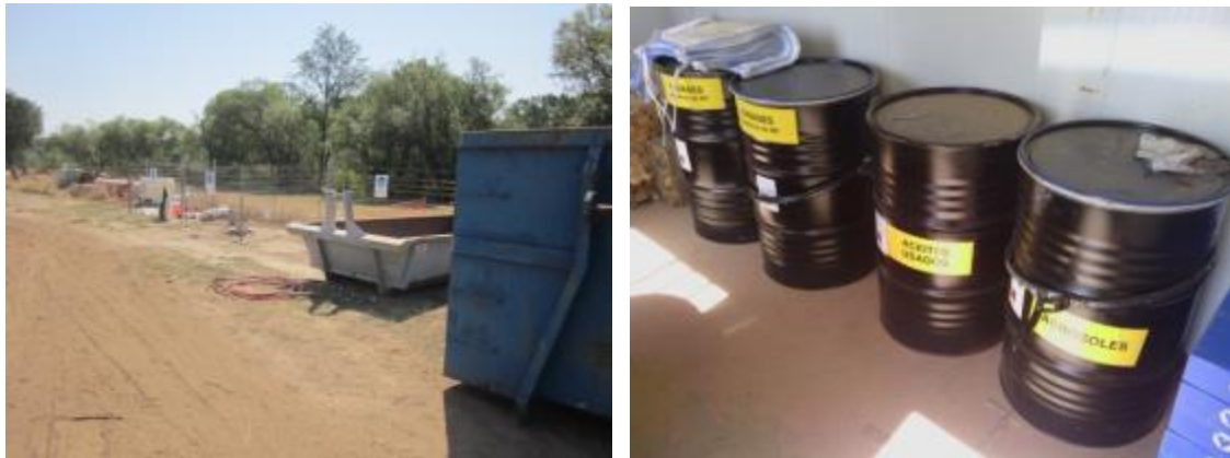
Instalación de puntos limpios para el almacenamiento de residuos (peligrosos y no peligrosos)
