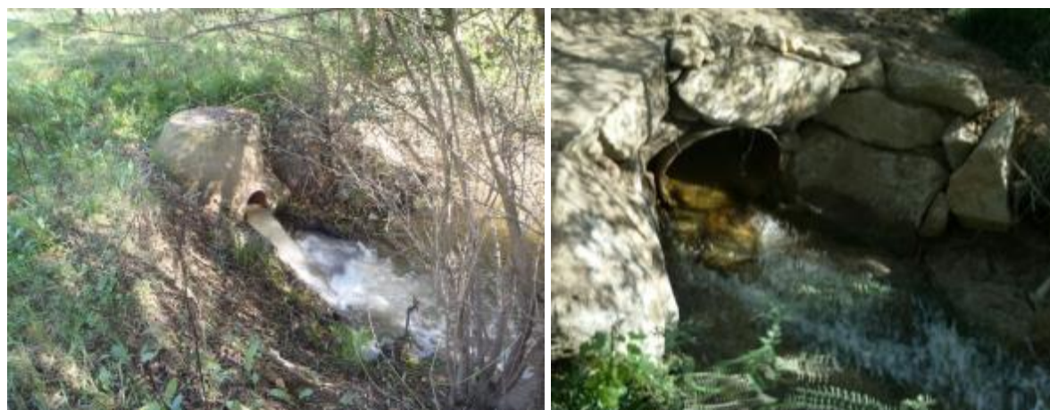
Vertido al río Alagón antes y después de las obras
