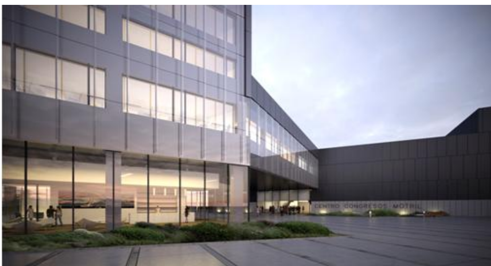
Vista exterior nocturna de la plaza de acceso (izquierda, Oficina Recepción Visitantes (Oficina de Turismo). Frente, Centro de Congresos
