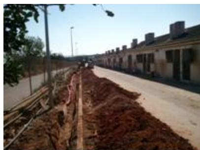
Se han ejecutado tres redes de pluviales independientes entre sí. La red de pluviales, que recoge todas las aguas pluviales de las cubiertas de los edificios del Centro Social; la red de pluviales que recoge las aguas pluviales drenadas
