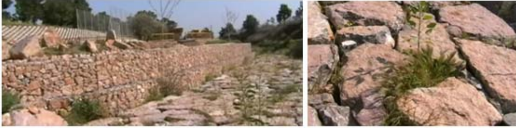
Detalle del encanchado de piedra que armoniza con los gaviones en los taludes y enriquece paisajísticamente el entorno.
