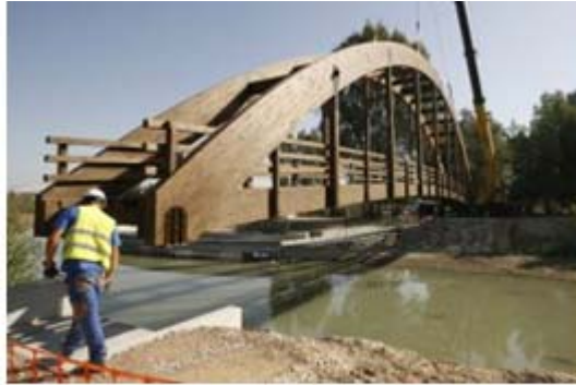
Una grúa procede a colocar la pasarela de madera encima de los estribos, ayer, sobre el cauce del río. :: JUAN LEAL. (publicado en La Verdad. 07.10.10)
