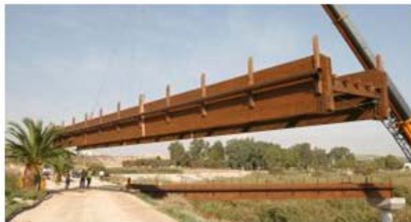
Una grúa procede a colocar uno de los tres tramos de la nueva pasarela de las ovejas, ayer por la mañana. :: JUAN LEA (Fotografías publicadas en La Verdad el 9/10/10)
