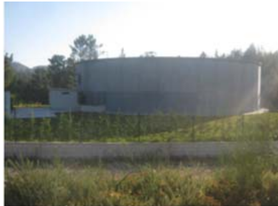
Vista general del depósito
