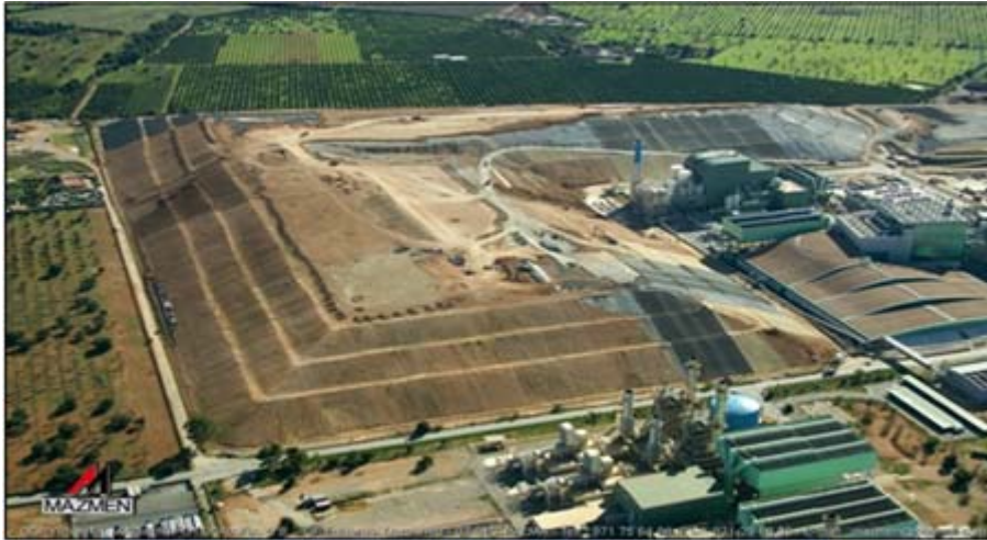
Imagen aérea tomada durante la ejecución de las obras.
