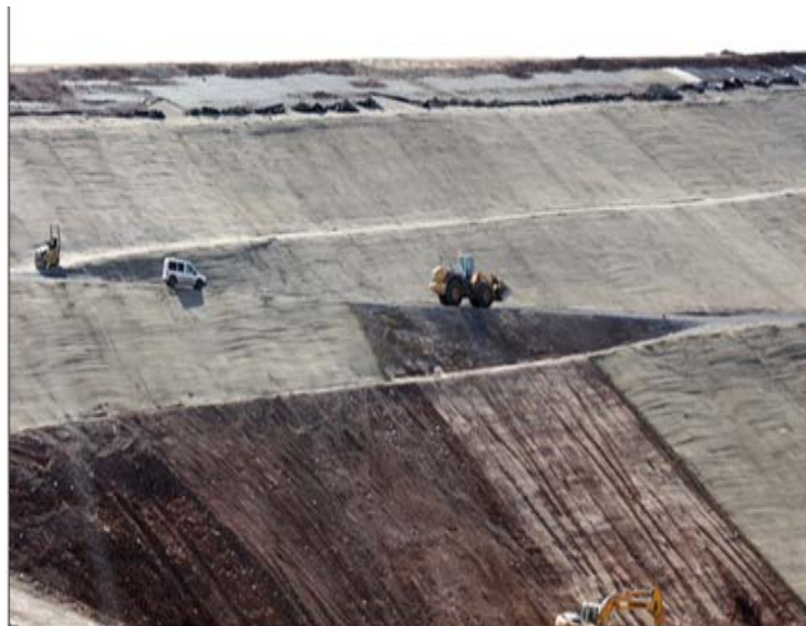
Visión general durante la colocación de la capa de Trisoplast .
