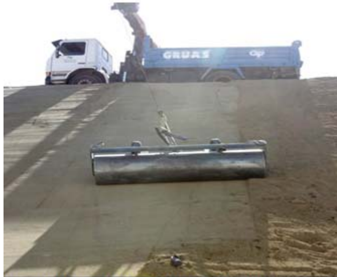
Instalación de la barrera mineral artificial Trisoplast .
