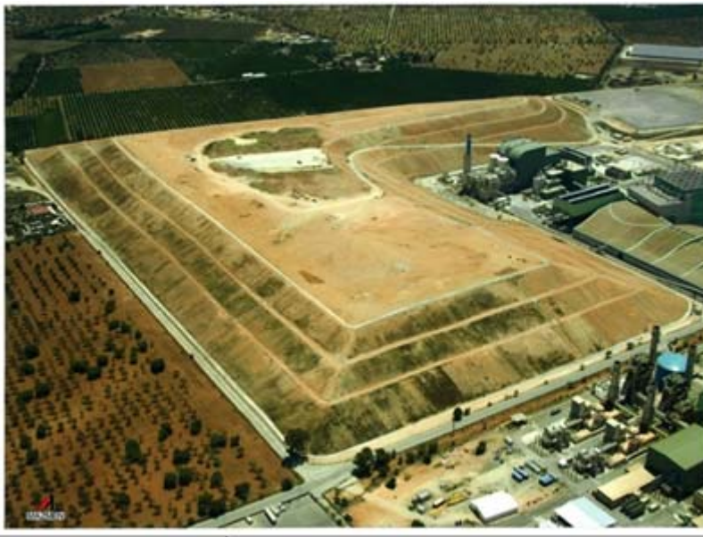
Foto aérea tomada en la fase final de las obras.
