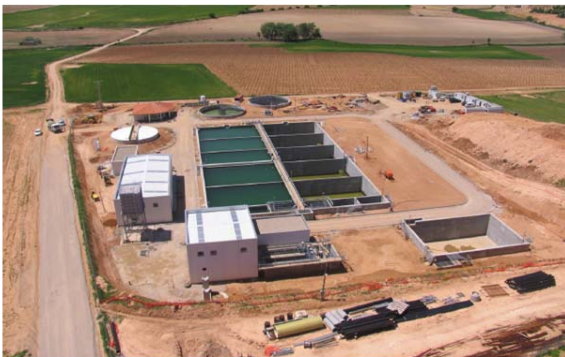
Fotografía aérea de la infraestructura en obras
