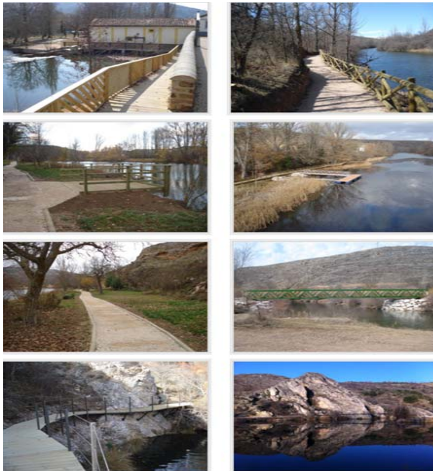
Fotografías de actuaciones ejecutadas en el entorno del río Duero en Soria.
