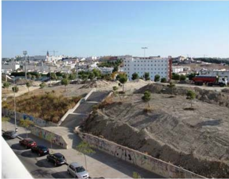
Trabajos de desmonte en el cerro de Santo Tomás
